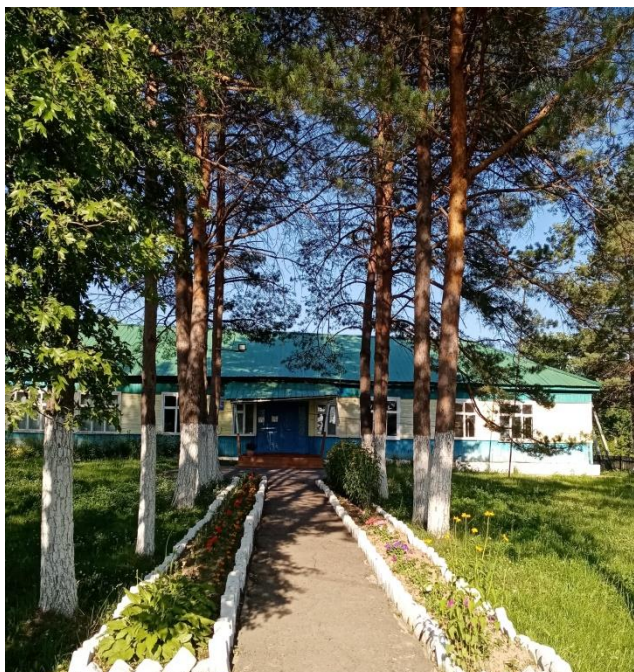
Фото № 3 Вход в здание.
